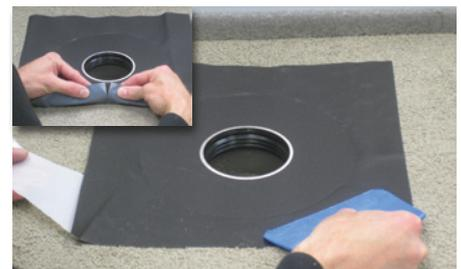
**6** Abdichtungsflansch an der rückseitig geschlitzten Stelle der Abdeckfolie etwas auseinander ziehen, Abdeckfolie greifen und durch schrittweises Abziehen am Untergrund ankleben. Im Anschluss komplette Verbundabdichtung nach unserer Verlegeanleitung erstellen.
