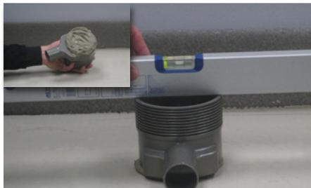
**2** Einbauposition am Untergrund säubern, Ablaufgehäuse mit Fliesenkleber am Untergrund fixieren und in Waage ausrichten. Rohrmuffe bei der Einbauhöhe berücksichtigen und ggfs. einstemmen.
