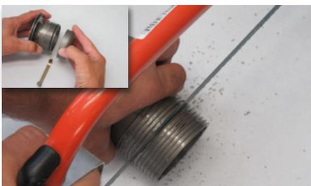
**7** Aufstockelement unter Berücksichtigung der Fliesenstärke winkelig in die Gummidichtung einsetzen. Metallspanne des Siphons lösen, Deckel und Dichtung entnehmen. Mittels Eisensäge auf das Einbaumaß von Ablaufkörper und Aufstockelement kürzen, wieder zusammensetzen und in das Aufstockelement einstecken.
