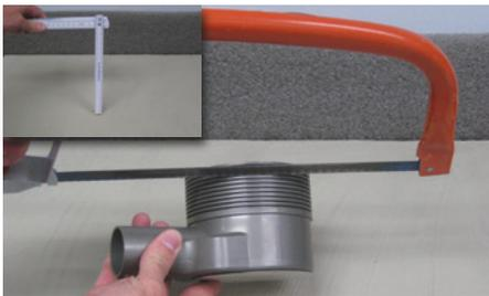
**1** Einbauhöhe bestimmen und optional das Ablaufgehäuse mit einer Eisensäge auf Höhe anpassen.
