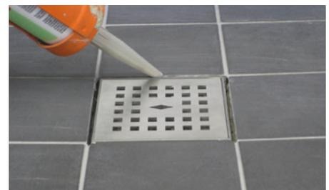
**9** Fliesenbelag nach den derzeit gültigen Normen und Regeln der Technik erstellen. Anschlussfuge zum Rostrahmen dauerelastisch mit neutralvernetztem Silikon versiegeln.
