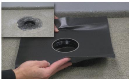
**5** Nach Trocknung des Estrichs ist dieser zu grundieren und nach der Trocknungszeit Bauschutzkappe entfernen. Edelstahlaufnahme mit Dichtgummi und werkseitig aufgebrachtem Abdichtungsflansch in das Ablaufgehäuse einsetzen.
