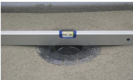
**4** Einbringen eines fachgerechten Estrichs zum Entwässerungssystem. Ein Gefälle von ca. 2 % ist zu berücksichtigen und einzuhalten.
